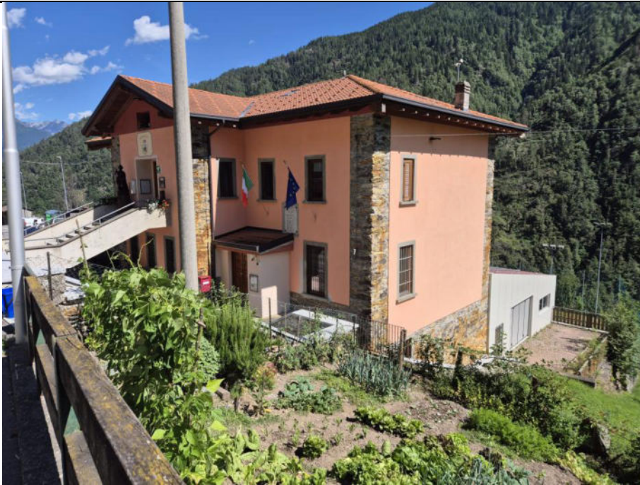
Immagine: foto dell'edificio oggetto di intervento
