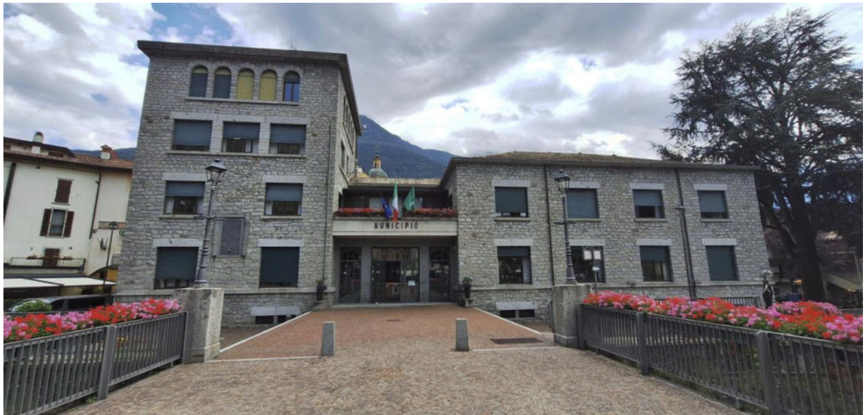
Immagine: fotografia dell'immobile allo stato di fatto
