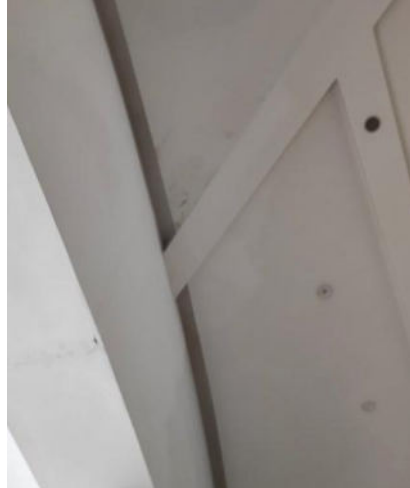
Immagine: fotografia dell'immobile allo stato di fatto
