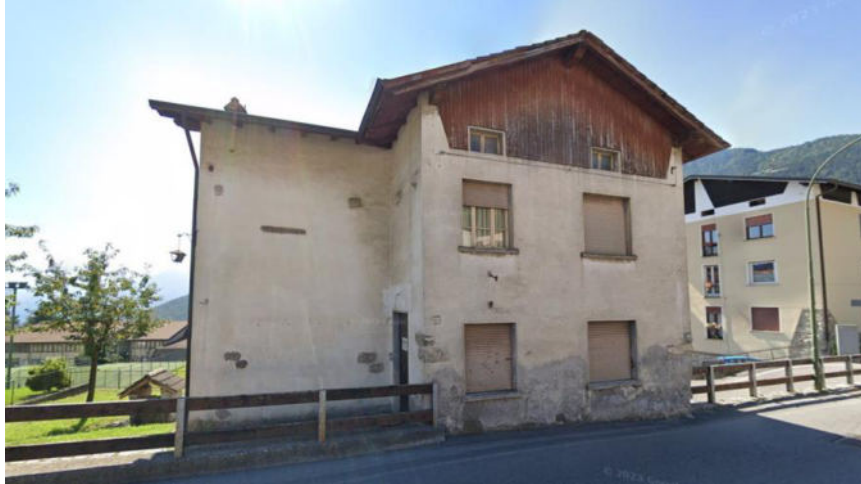
Immagine: fotografie dell'edificio oggetto di intervento
