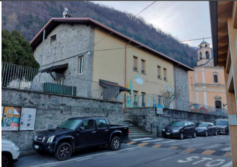
Immagine: fotografia dell'immobile allo stato di fatto
