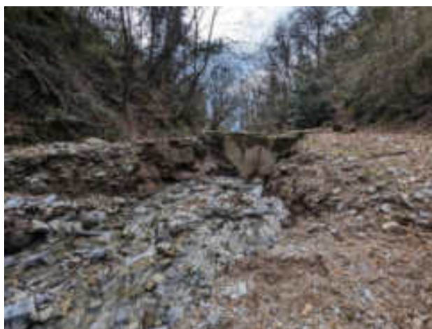
Briglia in cemento esistente sul Torrente Greggio
