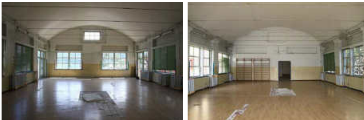
Figura 2: Spazio interno al corpo di fabbrica della palestra (interventi oggetto di finanziamenti Cariplo)
