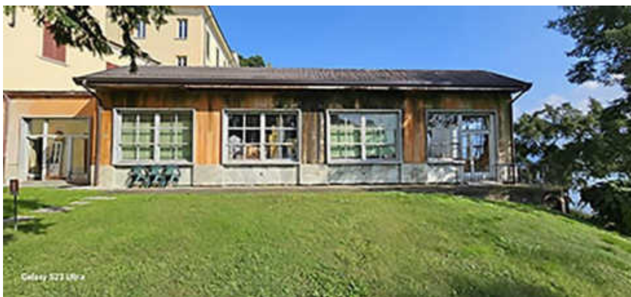
Figura 3: Foto degli spazi esterni e dei camminamenti (oggetto di finanziamenti Aree Interne )
