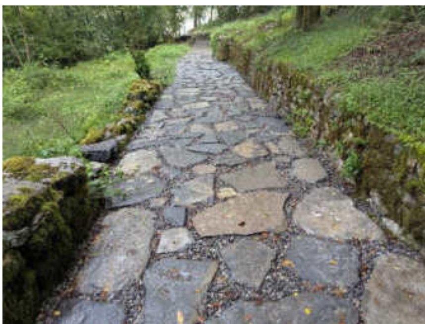
Sentiero carrabile drenante già realizzato
