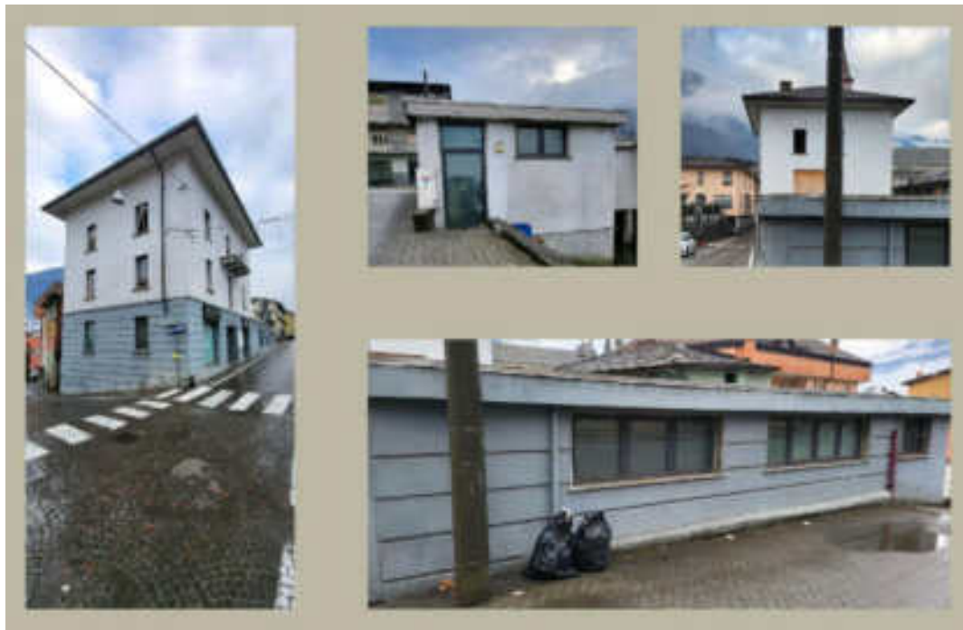
Figura: Documentazione fotografica dell'esistente
