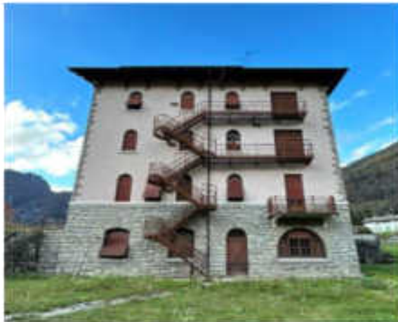
Prospetto Sud - Edificio A
