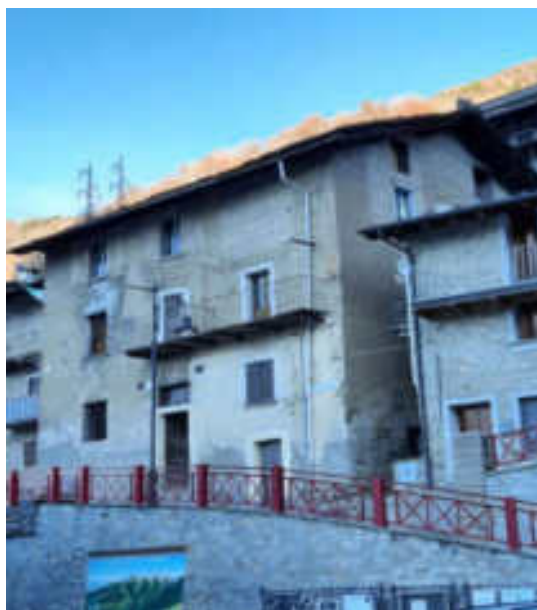
Figura 1: Immagine attuale del fabbricato "Canaloni"
