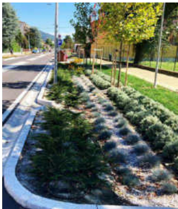
IMMAGINE 3-4: interventi di riferimento interventi di depavimentazione e trincea filtrante
